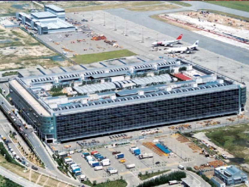
機場超級一號貨站 (香港) HACTL SuperTerminal 1 (Hong Kong)
